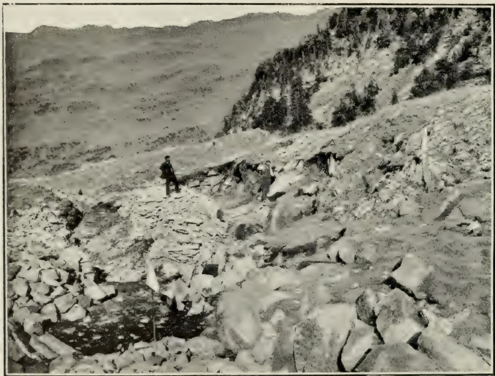
DESMUNTANT EL TERRER
