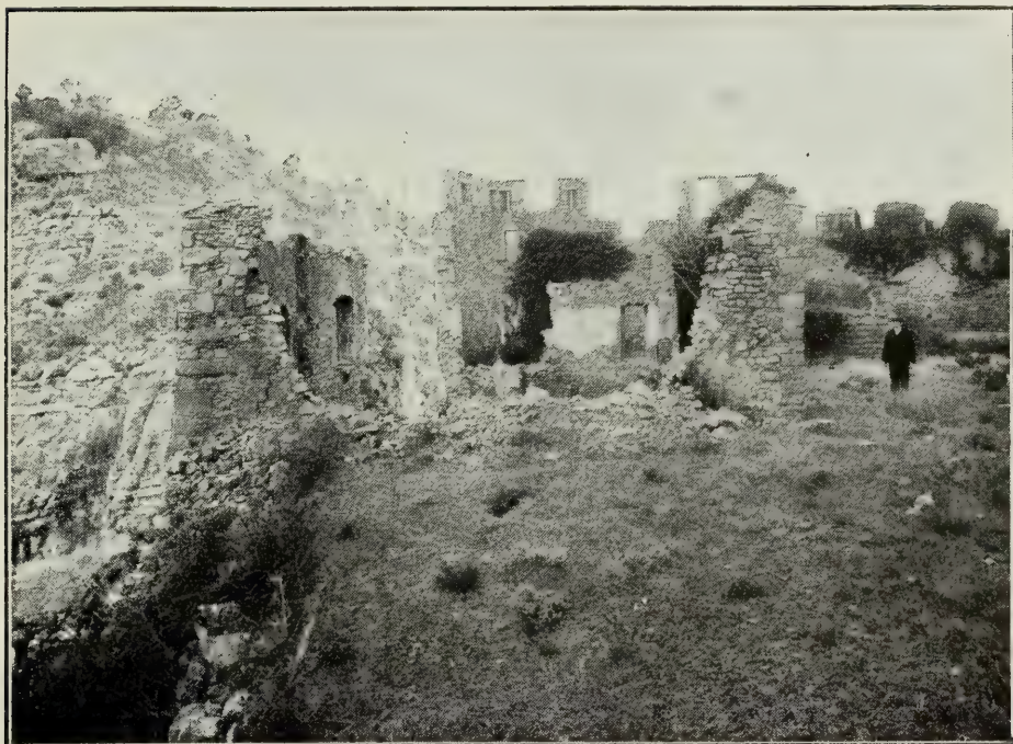
CONSTRUCCIONS AL CANTÓ DE PONENT
