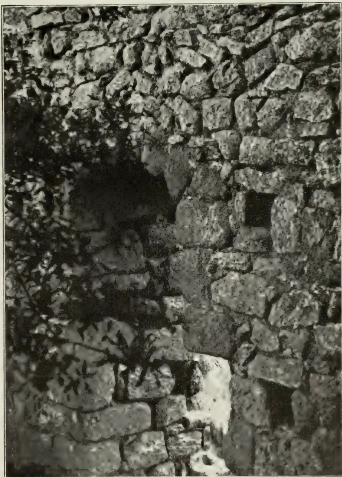
APARELL I FINESTRA DELS MURS, AL COSTAT DE LA TORRE D'HOMENATGE
